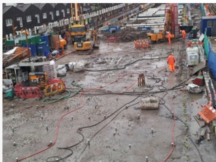
Londres, Angleterre, Injection par tube DURVINIL® S 40/50
