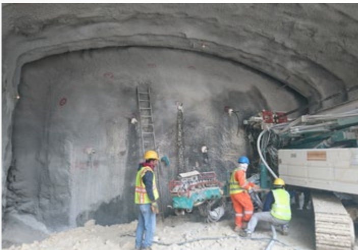
Doha, QATAR, boulons fibre de verre DURGLASS® ES 72 avec tube DURVINIL® 28/38
