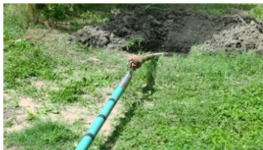
Installation de tubes DURVINIL® SUPER S FLUSH dans un forage dirigé
