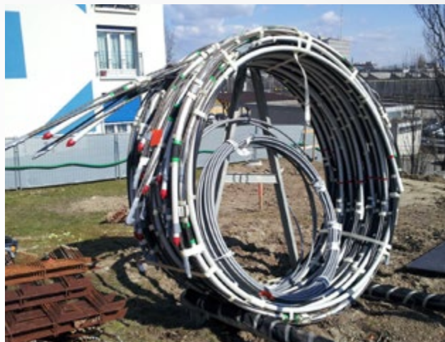
Tube DURVINIL® A 27/34 enroulé dans un tirant câble
